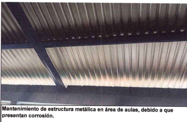
Foto 2: Sustrucción de láminas por deterioro por el paso del tiempo, imagen parcial de donde se localiza el salón de usos múltiples.
