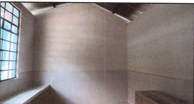
Foto 6: Cernido de pared en area de cocina para mejorar la higiene y evitar la humedad.
